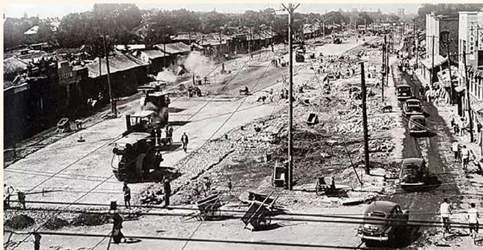
▲ 1956年，西单路口西向进行打通复兴门内大街工程
