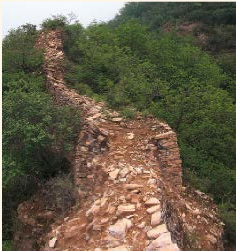
▲天津关二道城子城墙
